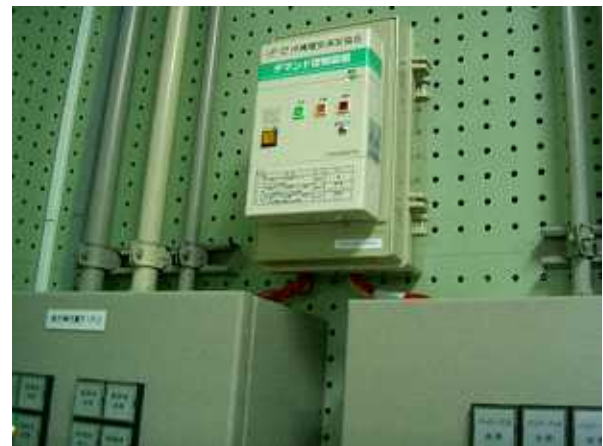
（写真1）デマンドコントロール装置警報機
